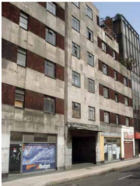
Edificio en Paseo de la Reforma donde residió el matrimonio, ahora clausurado.
